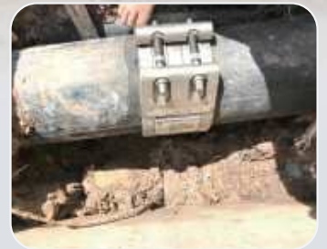
▶ PE pipe repair work
