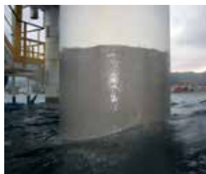
Confère une protection à long terme contre la corrosion dans les zones d'action des vagues
