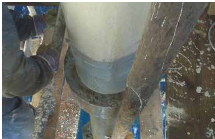
Belzona 5831LT est tolérant à l'humidité et convient idéalement aux utilisations offshore
